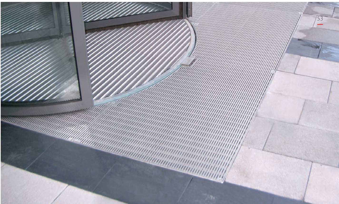
Werkseitig vorgerichtete Verbindung bei mehreren Wannenelementen
