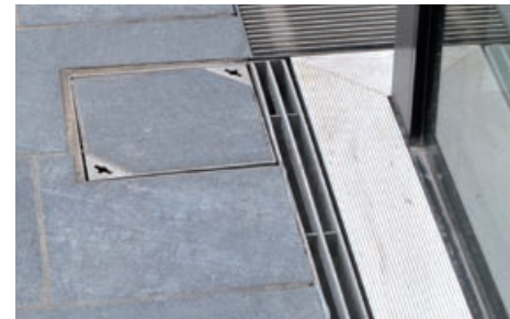
Schlitzrinne mit Mittelsteg
