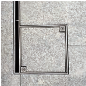
Schlitzrinne mit Revisionskasten und befüllter Abdeckung mit Oberflächenbelag
