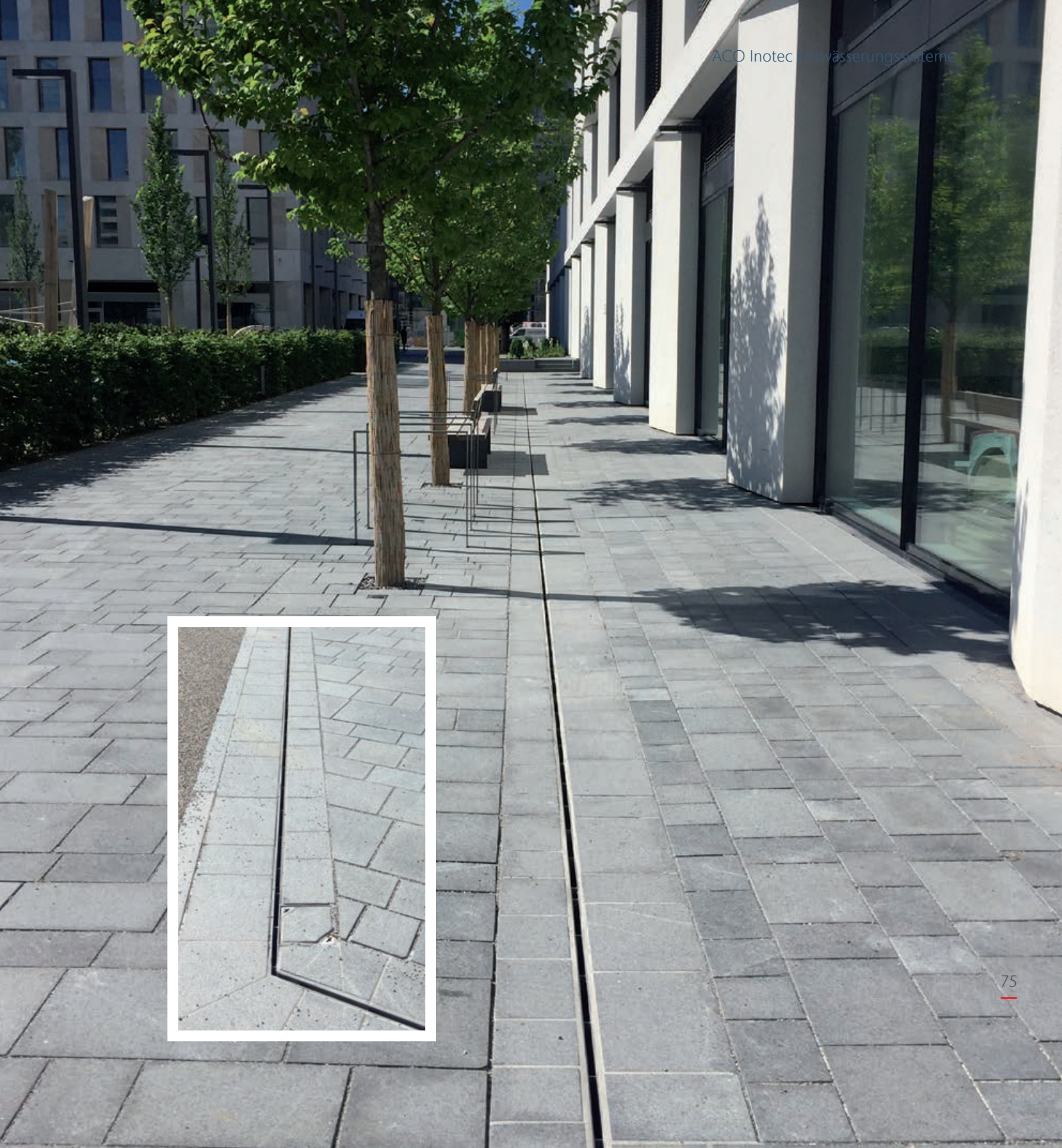
Sonderlösung: Symmetrische Schlitzrinne mit Sichtstegen
