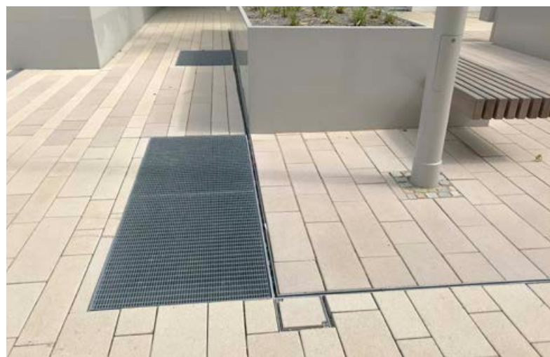
Sonderlösung: Symmetrische Schlitzrinne mit Sichtstegen
