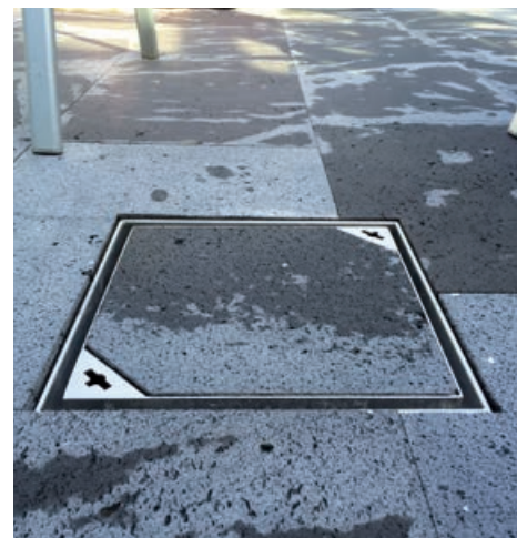
ACO Inotec Punktablauf mit ausfüllbarer Abdeckung in Sonderanfertigung
