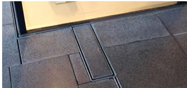
Schlitzrinne mit Revisionskasten und gefliester Einsatzwanne
